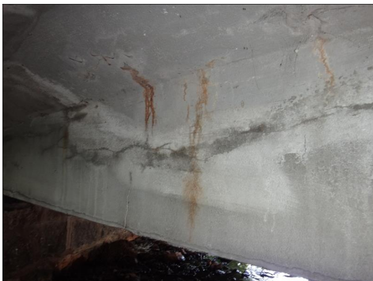
Podhled NK - opětovné projevení předchozích poruch
