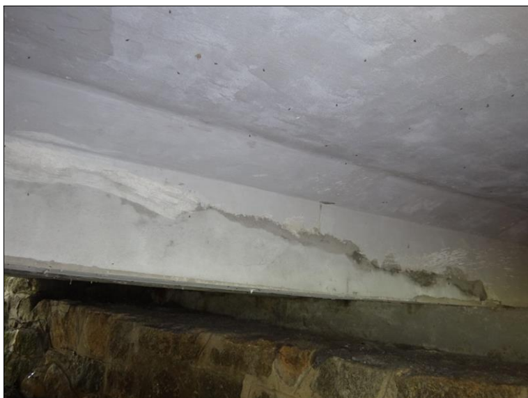
Podhled NK - opětovné projevení předchozích poruch
