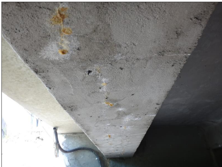
Podhled NK - opětovné projevení předchozích poruch
