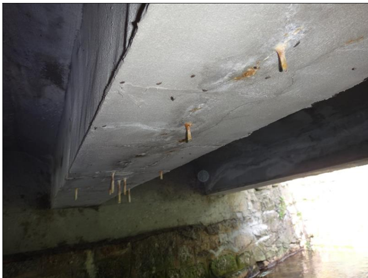
Podhled NK - opětovné projevení předchozích poruch
