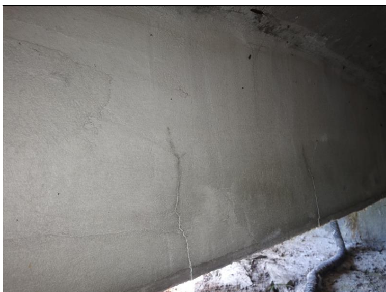
Podhled NK - opětovné projevení předchozích poruch
